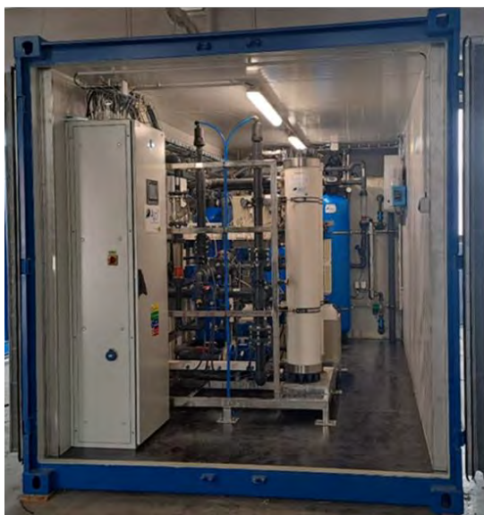
Obrázek 3: Úpravna povrchové vody v kontejneru
