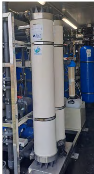
Obrázek 3: Úpravna povrchové vody v kontejneru
