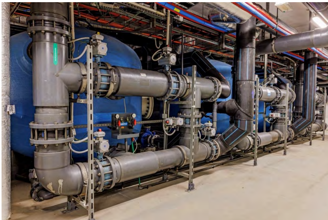
Obrázek 2: Stávající technologie ve strojovně
