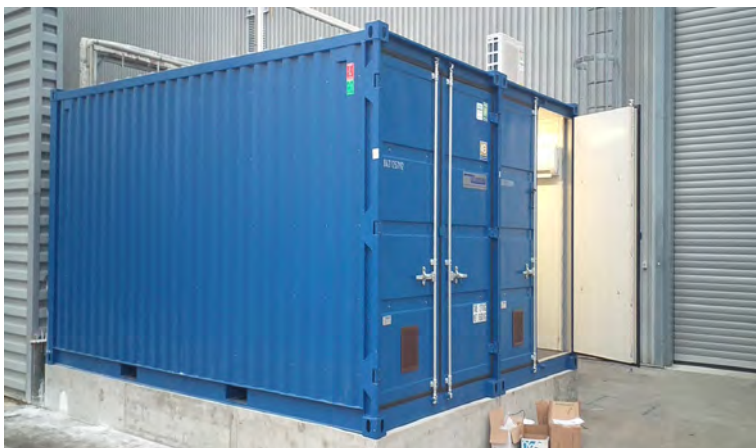
Obr. 5.3 - Pohled na sestavu kontejnerů
